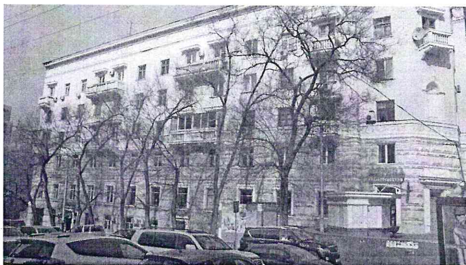
Юго-западный фасад объекта культурного наследия
