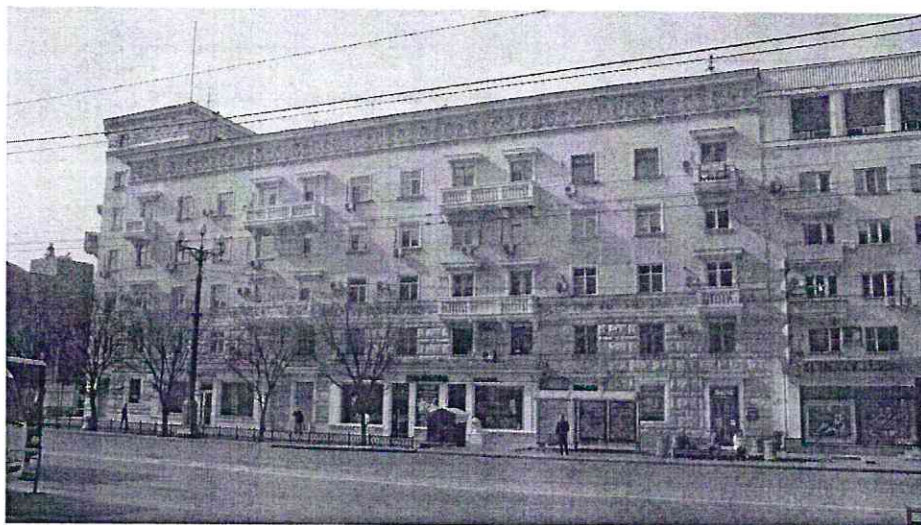
Юго-восточный фасад объекта культурного наследия
