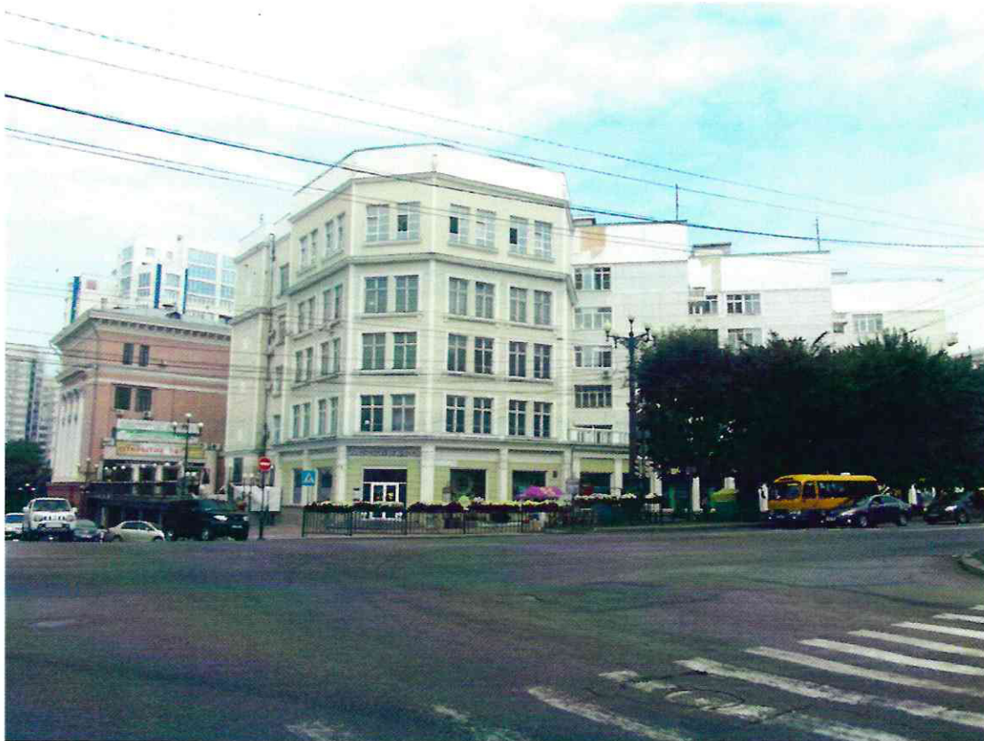
Угловой пятиэтажный объем спортивно-оздоровительного комплекса со срезанным углом на пересечении улиц Муравьева-Амурского и Дзержинского
