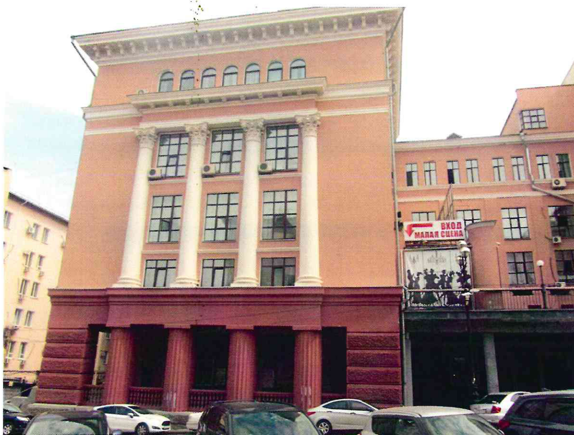
Юго-восточный фасад театрального блока
