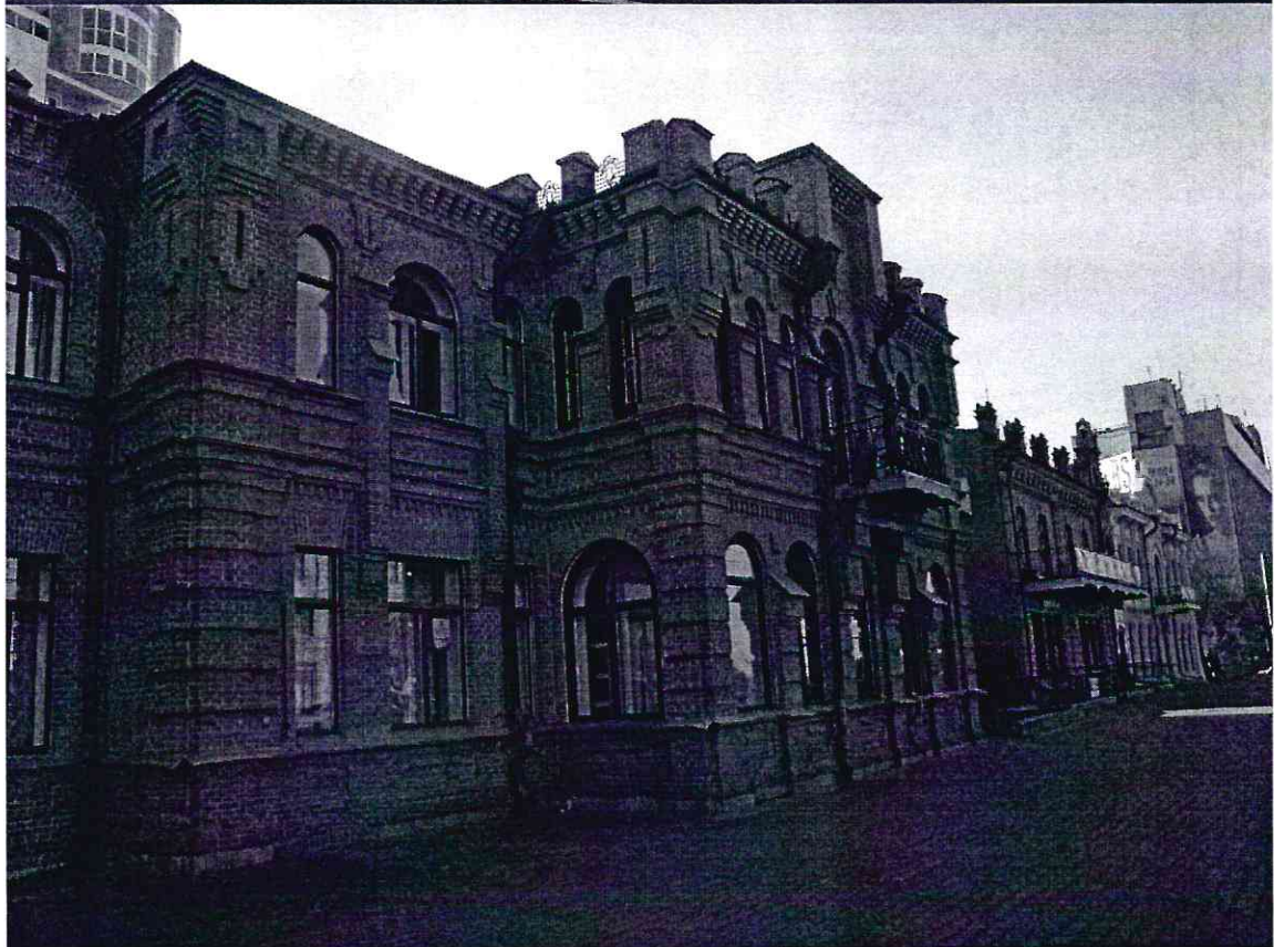
Фасад объекта культурного наследия со стороны улицы Муравьева-Амурского
